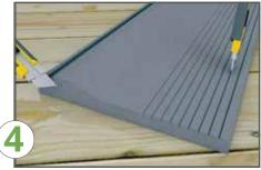
Dämmplatten einsetzen. Die Dämmung benötigt am Sturz und oberhalb des Blendrahmens einen Anschlag (z. B. Winkel setzen).
