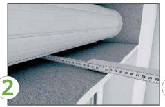
Messen Sie den Kasteninnenraum, um die Länge und Stärke der Dämmplatten festzulegen.
