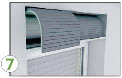
Dämmplatten mit Montageschaum am Anschlag und in den Stoßbereichen verkleben und abdichten.
